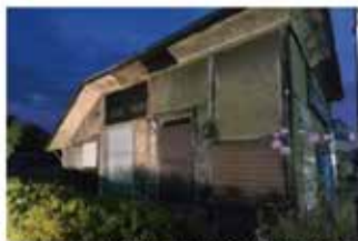
夏、旧 高畠駅前在る。旧 大坂屋売店の西側壁面外壁・内壁はボロボロでした。修繕の為に作業開始
